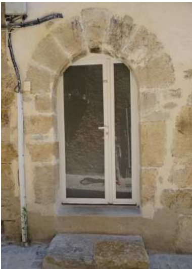
Les menuiseries doivent respecter les dimensions et la forme des ouvertures dans le mur
