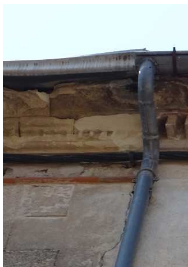
Détail d'une corniche en pierre sculptée sur frise à décor en denticules
