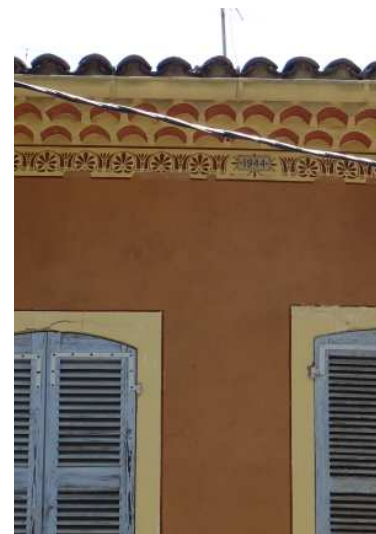
Frise peinte sous deux rangée de génoise et filet rouge délimitant les encadrements des baies
