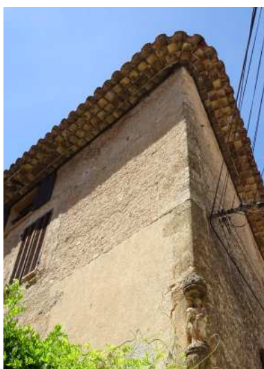
Détail du retour courbe de la génoise dans l'angle d'une maison décorée d'une niche avec statue
