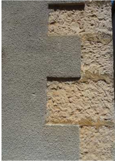
Le resurfaçage rapportée sur ces façades est trop épais. Quand l'enduit rapporté ne se termine pas à fil de façade la composition apparaît alourdie et pas mise en valeur.
