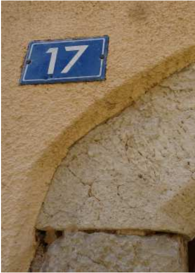
Le resurfaçage rapportée sur ces façades est trop épais. Quand l'enduit rapporté ne se termine pas à fil de façade la composition apparaît alourdie et pas mise en valeur.
